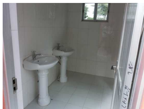
新設されたトイレ
